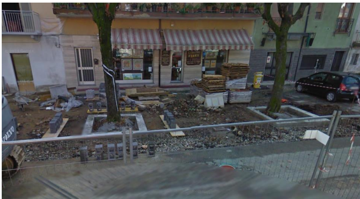
Figura 1.2: aspetto durante i lavori che hanno portato all'attuale disposizione delle aiuole. Si nota anche lo spandimento (senza ragione tecnica) di calcestruzzo direttamente sulla zolla radicale.
